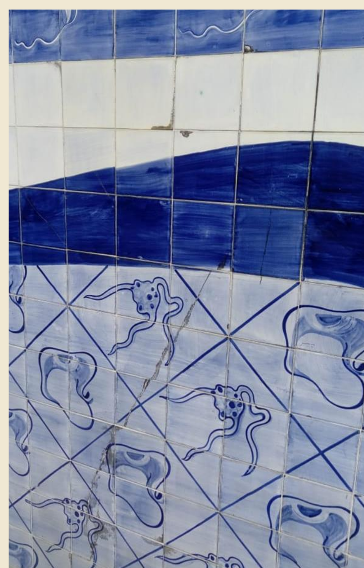
Atividade no pavilhão Arthur Neiva sobre mapeamento de danos. Fonte: autoral.
