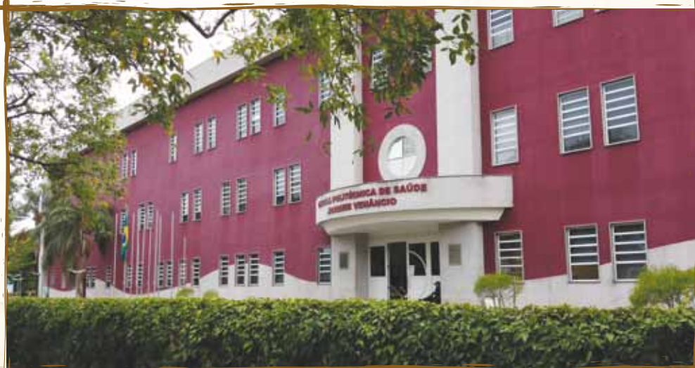
Foto 7 – Prédio da EPSJV
