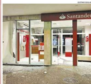
Destruição. Uma das três agências depredadas por vândalos ontem à noite
