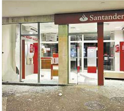
Destruição. Uma das três agências depredadas por vândalos ontem à noite
