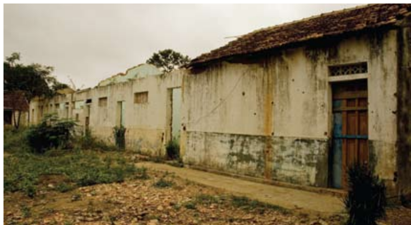
Escola abandonada no assentamento Zumbi 4
