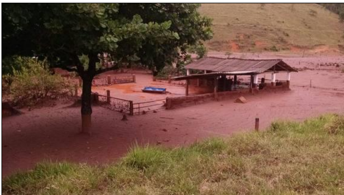
Fotografia 1: Propriedade rural com estruturas como curral e barracão impactados pela lama de rejeitos no município de Barra Longa, nas margens do rio Gualaxo do Norte.
